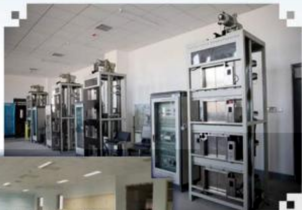
智能电梯安装调试 维护训练场所
